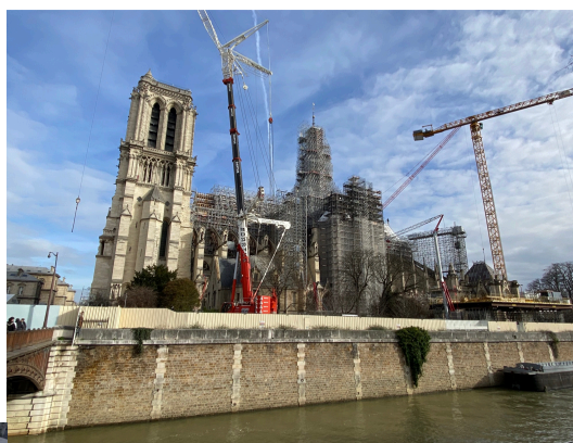
再建工事が進むノートルダム大聖堂
