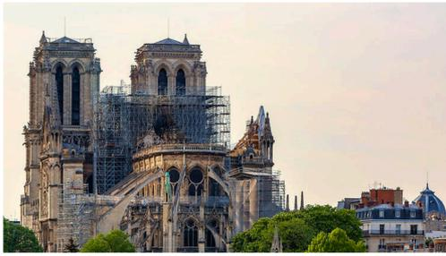
火災から丁度4年が過ぎた今年の4月15日。ノートルダム大聖堂の修復は進み、火災で焼け落ちた「ユジェーヌ・ヴィオレ・ル・デュックの尖塔」の再建が始まった。1859年8月天に向けて高々と建立された高さ96m、1400近い檜材パーツと鉛で造られた尖塔で、当時と同じ手法で同一の複製を作る修復作業である。火災直後から尖塔の複製に関わっている
