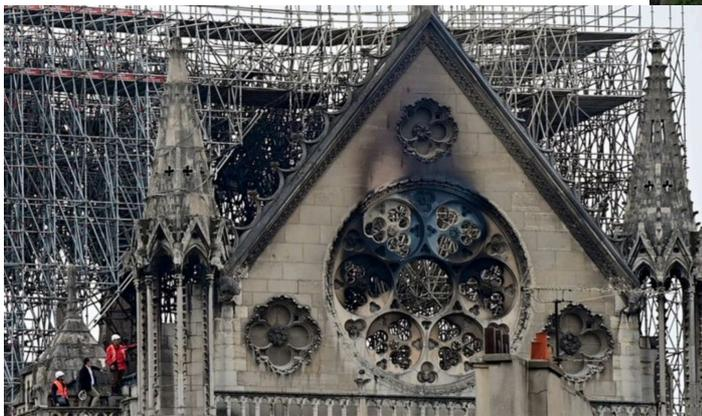
がかけられ、聖堂内に新たな足場が組まれた。鉛の屋根が燃えた際に拡散した粉塵が引き起こす鉛中毒対策は、今も工事に大きなブレーキをかけている。大規模で危険を伴う修復工事だが、屋根を支える木組みの樑の木が伐採され始めた。入念に選別された樹齢200-300年の原木を切り出し、これから1-2年乾燥させて、鉛の屋根を支える
